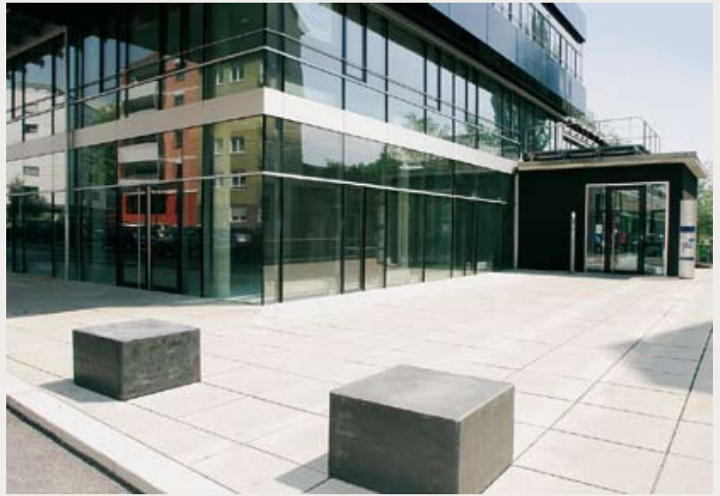
Businesspark B 2 , Bartholomäusstraße, Nürnberg
